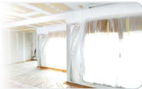
Preparación de la obra Preparação da obra
