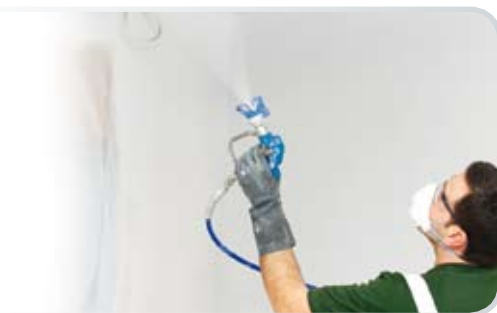
Aplicar las manos de enlucido Aplicar as demãos de revestimento
